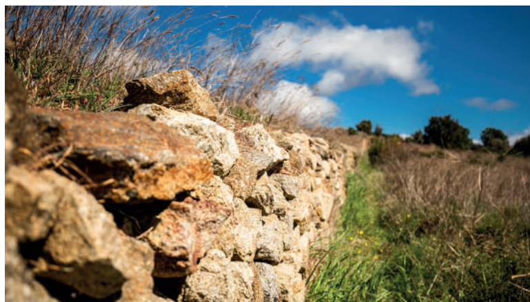
Muret de pedra seca
