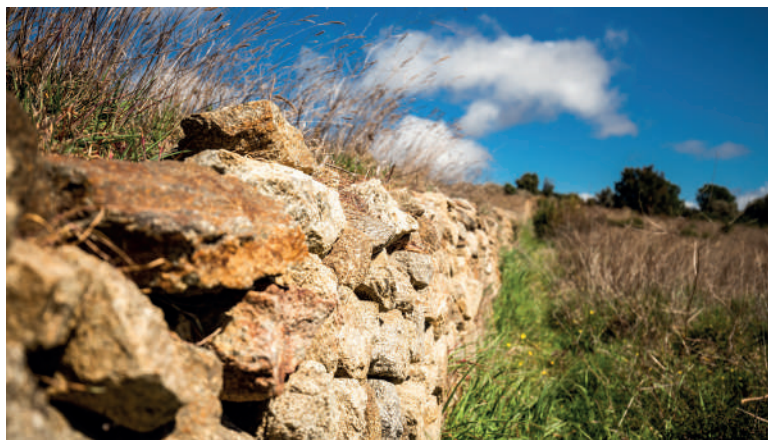
Muret en pierre sèche
