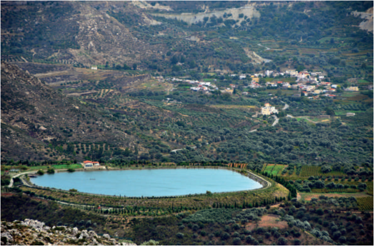
Γέργερη, λιμνοδεξαμενή "Διγενή"
